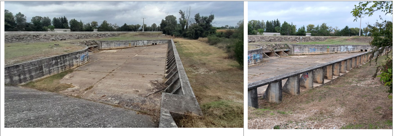
Figure 84 Rancure à Oraison : passage sous le canal EDF
