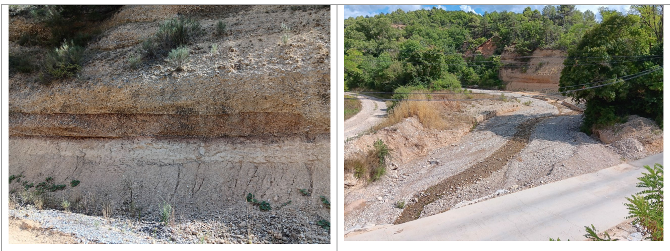
Figure 117 Secteur singulier en amont du gué d'Entrevennes. À gauche : affleurement de la formation des poudingues de Valensole montrant une succession de couches meubles susceptibles d'alimenter le lit en cas de déstabilisation du talus. À droite : vue du lit élargi au niveau du gué.
