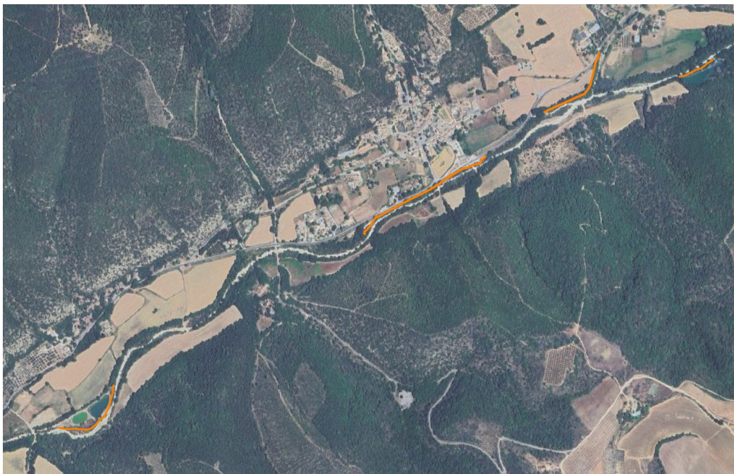
Figure 86 Rancure : ouvrages longitudinaux au niveau du Castellet (route, mur et protections de berges)
