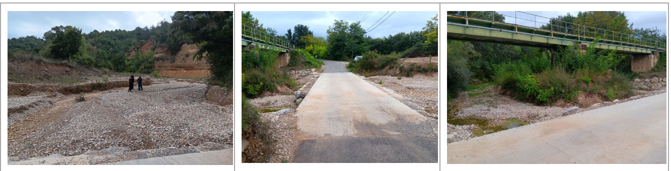
Figure 82 Rancure: passage à gué de la route d'Entrevennes _vue amont (à gauche) et vue aval (à droite)
