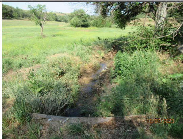
Eau alimentant le bassin
