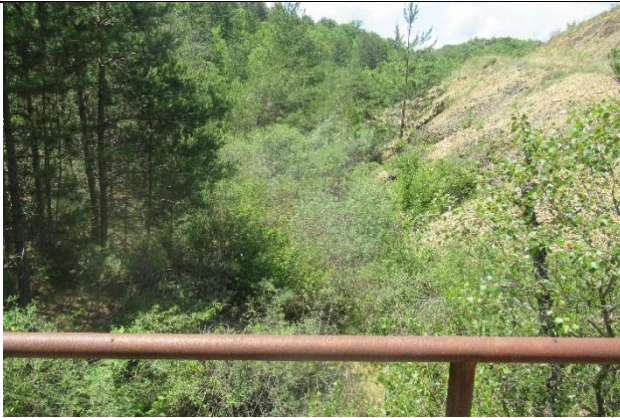
Ancien Pont Chadeauvin-la Roueirie
