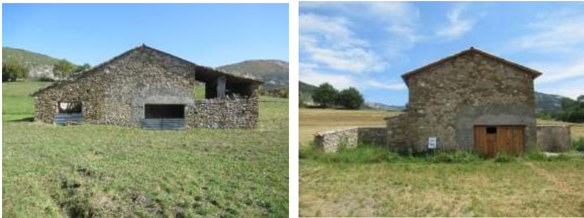
Figure 2 : Photo avant (à gauche) et après travaux (à droite)
