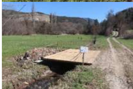
Figure 9 : Retrait d'ouvrages et remplacement par des passerelles
