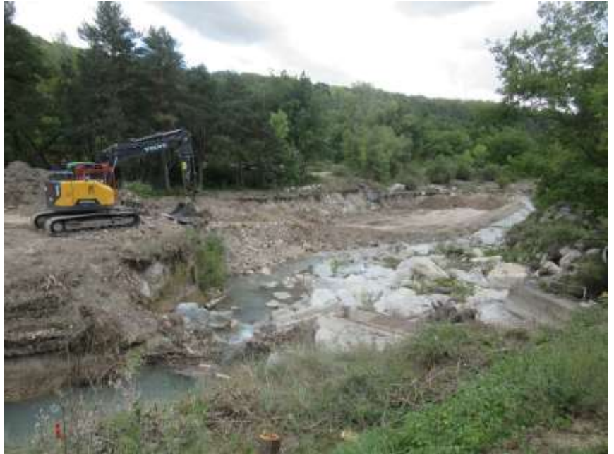
Figure 3 : Travaux de restauration du lit de l'Estoublaisse
