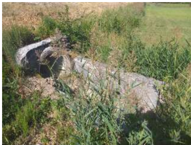
Figure 72 : ouvrage de franchissement de la RD4085 surélevé par rapport au Terrain Naturel et drainant les eaux du fossé bordurier (Cf. Repère A – carte suivante)
