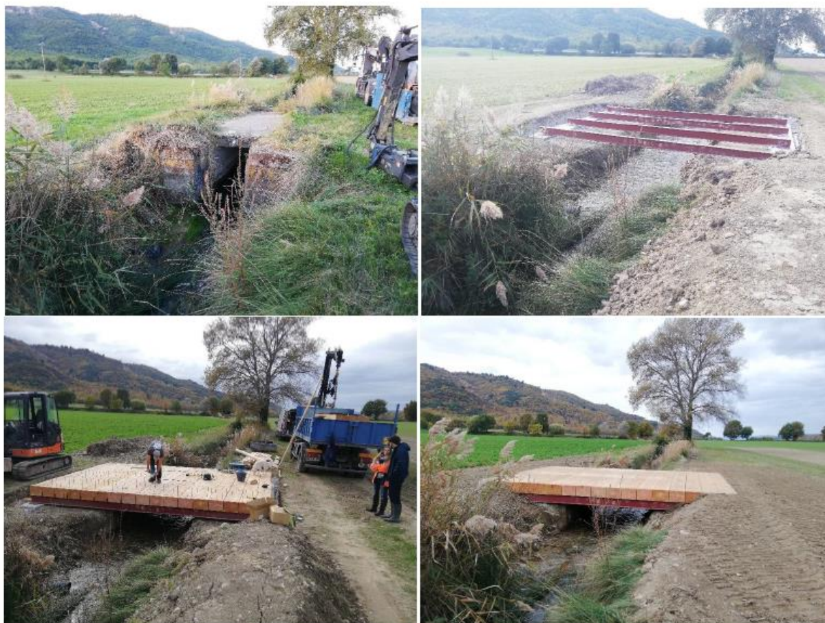
Figure 10 : Avant/après retrait et remplacement de l'ouvrage n°4, vu par l'amont.
