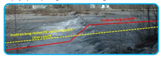
Le profil en long cible de la Bléone sera obtenu en abaissant partiellement (- 1 m environ) les seuils du Grand Pont et du Pont Beau de Rochas et en supprimant complètement le seuil du pont des Chemins de Fer de Provence ainsi que celui de la canalisation d'eaux usées de Gaubert.
